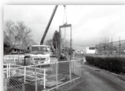
取水ゲート補修
