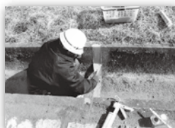
用水路目地補修
